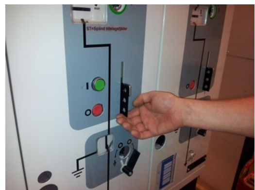
Bild 4. Förreglingsväljaren skjuts upp i sitt övre läge.
