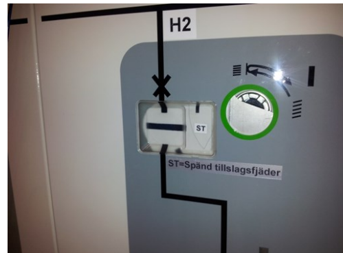
Bild 2. Indikeringsfönstret vid läge ST (Spänd Tillslagsfjäder).
